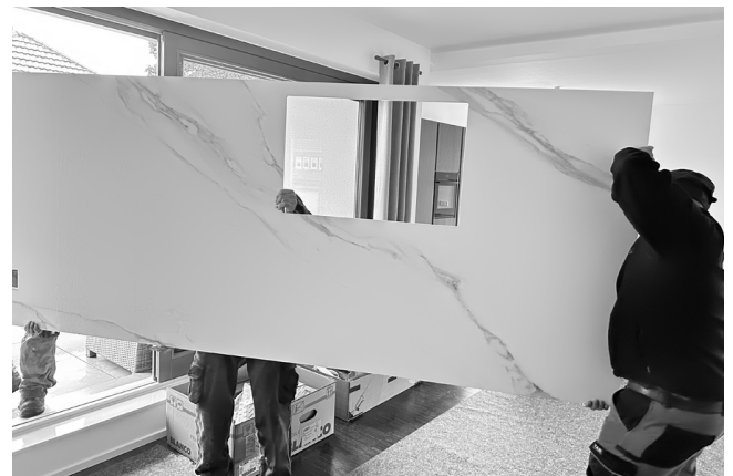
Staubfreie Montage durch 100%ige Vorfertigung
